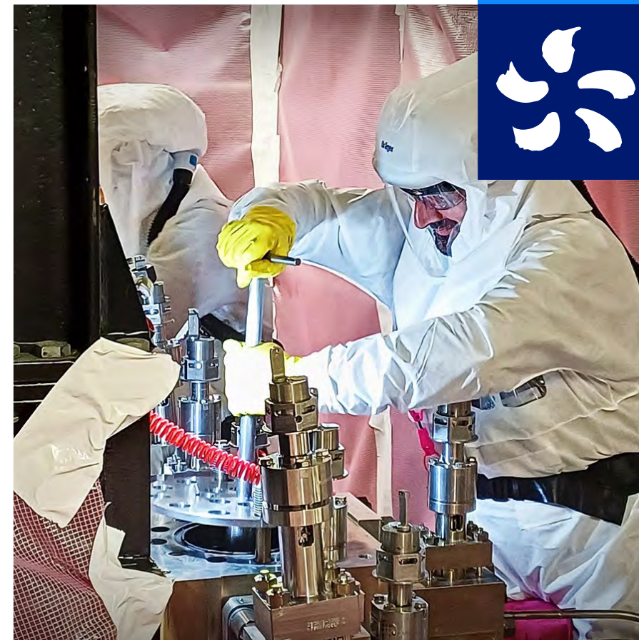
Intervention sur les soupapes du pressuriseur
